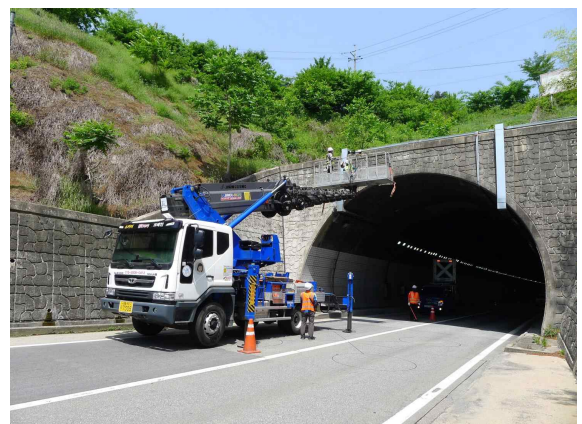
터널 내부 및 진·출입부 고소작업차량을 이용한 외관조사를 실시할 예정
