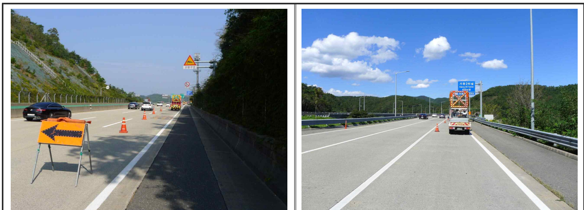
공사안내 입간판 설치 및 교통통제를 실시할 예정
