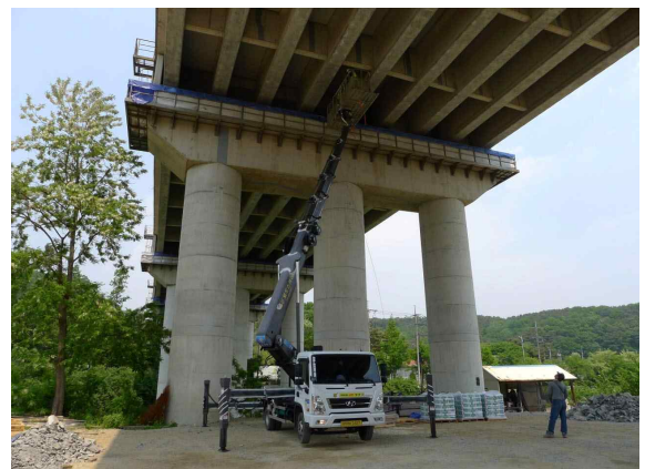
교량 고소작업차량을 이용한 외관조사를 실시할 예정
