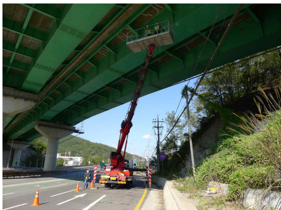
교량 고소작업차량을 이용한 외관조사를 실시할 예정
